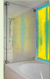
Bild 2 | Anwendungs- beispiel Wandheizung (Infrarotbildmontage) im Bad.
