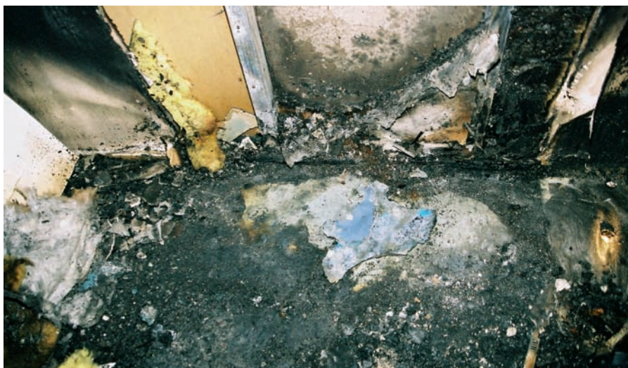
Bild 4 | Überreste des Mülleimers und der Mülltüte am Fuß des Brandkegels
