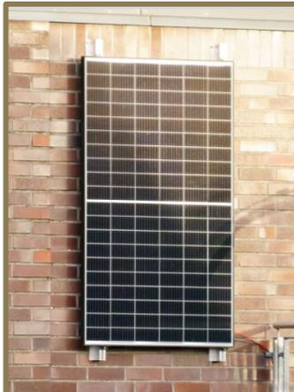
Bild 4 / Wandmontage eines PV-Moduls
