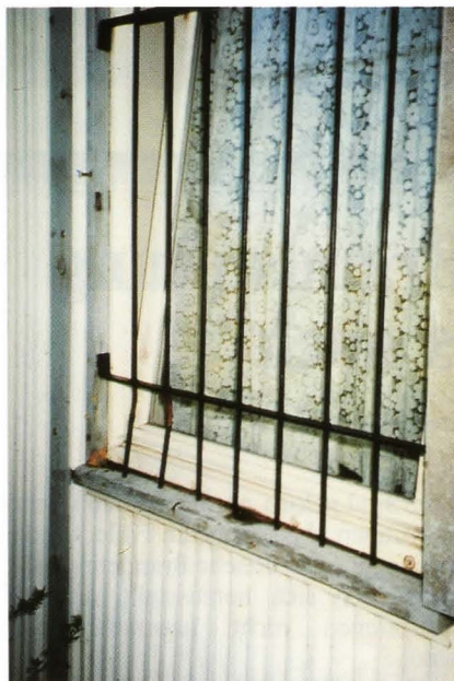
Bild 6 und Bild 7: Dieses Gitter wurde an einem schwachen Holzrahmen angeschraubt, welcher je Längsseite mit nur je 3 Schrauben am Gebäude befestigt war. Es ist somit verständlich, daß bei der Überwindung dieses Gitters der Holzrahmen splitterte und herausbrach.
