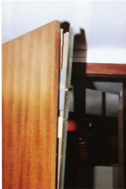
Bild 5: Es ist durchaus sinnvoll, gute, massive und stabile Türelemente mit einer Mehrfachverriegelung nachzurüsten. Besteht allerdings die Mittellage des Türblattes z. B. aus Kunststoffwaben, Pappe- oder Papierwaben, ist das als Fehlinvestition anzusehen.
