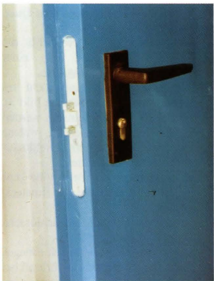
Bild 2: Türschlösser dieser Art finden in zunehmender Anzahl Einsatz bei Gewerbe- und Industriebetrieben. Die dort eingesetzten Einsteckschlösser besitzen nicht den sonst üblichen Riegel ca. 3–5 cm unterhalb der Falle. Durch den technischen Aufbau schließen diese Riegel nur eintourig (ca. 7 mm) aus. Bei dem vorhandenen Luftspalt zwischen Tür und Zarge bedeutet dies einen maximalen Einschluß von 3–5 mm in der Schließblechseite.
