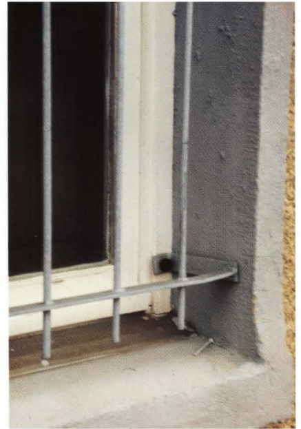
Bild 8 und 9: An den Fensterrahmen befestigte Vergitterungen sind leicht entfernbar.
