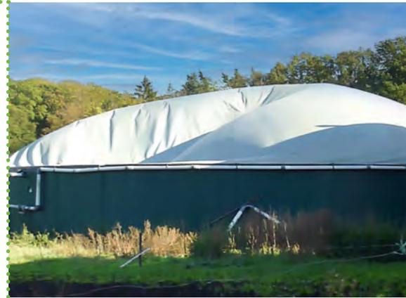
**Bild 10** / Instabile Wetterschutzfolie durch zu geringen Stützluftdruck
