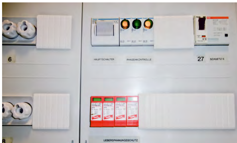
Bild 6 / Überspannungsableiter Typ 2+3 in Unterverteilung (als Teil eines Überspannungskonzepts)
